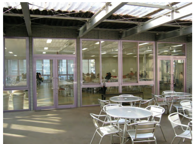
工学部総合会館
