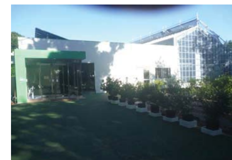
太陽光発電設備を備えた植物工場
