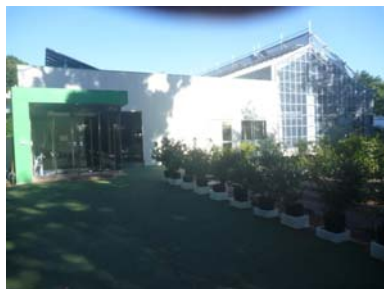
（太陽光発電設備を備えた植物工場）
