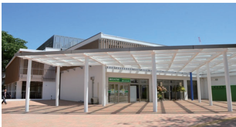
工学部総合会館
