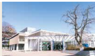
工学部総合会館
